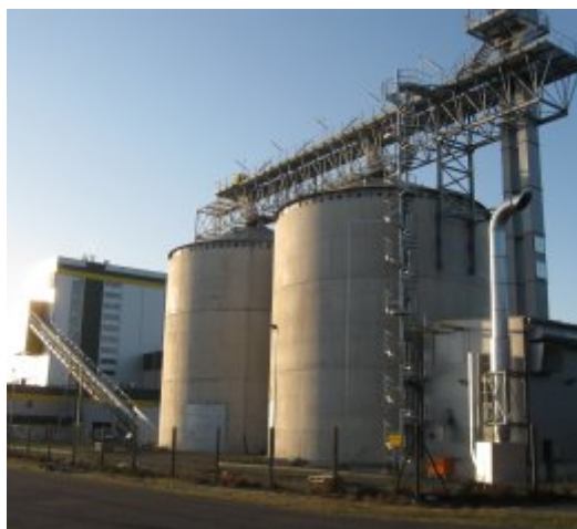
Manutention développée par Scaldis, photo Cofely
